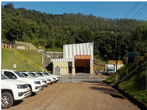
Foto 7 – Casa de força da PCH Salto Natal.
