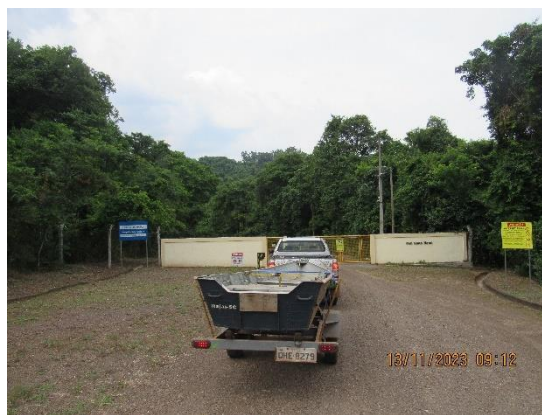
Figura 43 - Sistema de drenagem devidamente instalado em via de acesso. Fonte: Cedro Inteligência Ambiental, Nov/2023.
