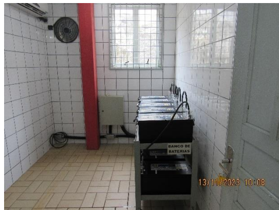
Figura 31 - Banco de baterias. Fonte: Cedro Inteligência Ambiental, Nov/2023.
