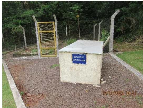
Figura 53 - Estação de compostagem. Fonte: Cedro Inteligência Ambiental, Nov/2023.
