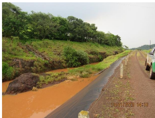
Figura 103 – Aspecto do ponto P21. Fonte: Cedro Inteligência Ambiental, Nov/2023.
