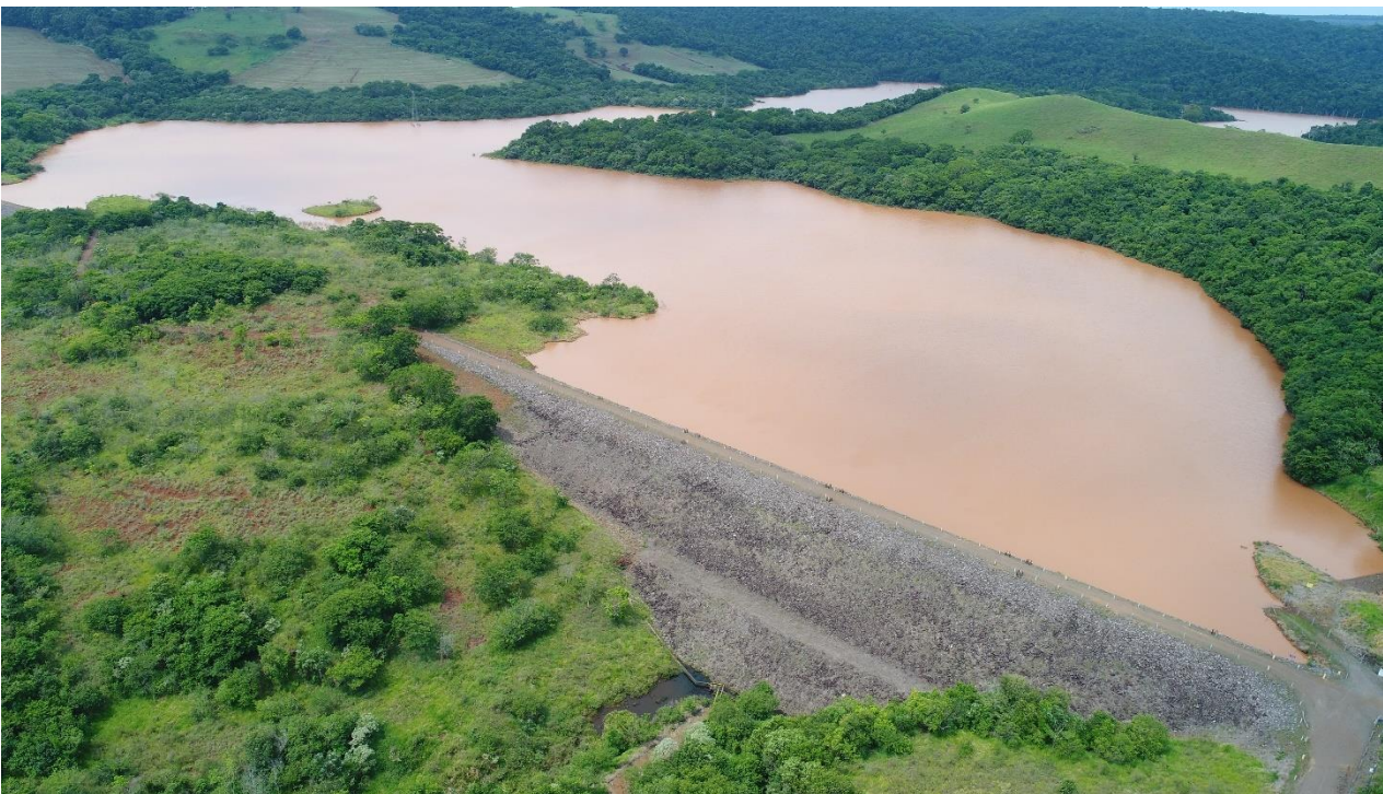
Foto 3 – Vista geral do reservatório da PCH Salto Natal – Coordenada da foto: -24.085402° / -52.299628°.
