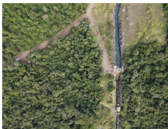
Figura 113 - Aspecto aéreo da vegetação nas imediações das vias de acesso, canal de adução e conduto forçado.
