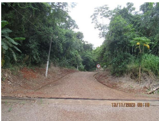
Figura 42 - Sistema de drenagem em ambos os lados da via de acesso. Fonte: Cedro Inteligência Ambiental, Nov/2023.
