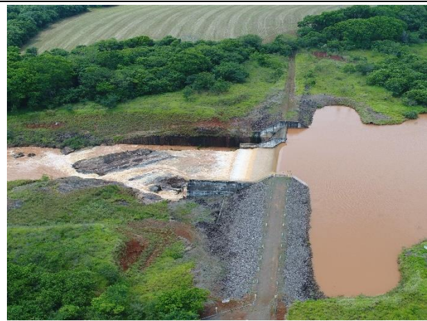
Foto 2 – Registro do vertedouro e vazão sanitária da PCH Salto Natal.
