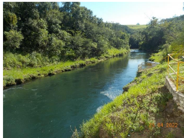
Foto 8 – Registro do canal de fuga da PCH Salto Natal.
