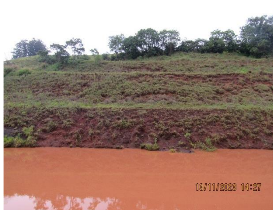
Figura 98 – Aspecto do ponto P18. Fonte: Cedro Inteligência Ambiental, Nov/2023.
