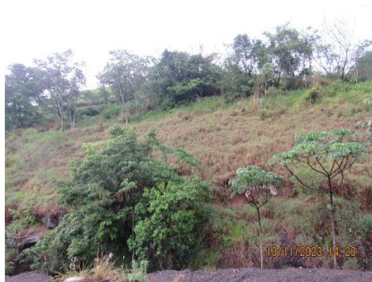
Figura 96 – Aspecto do ponto P17. Fonte: Cedro Inteligência Ambiental, Nov/2023.
