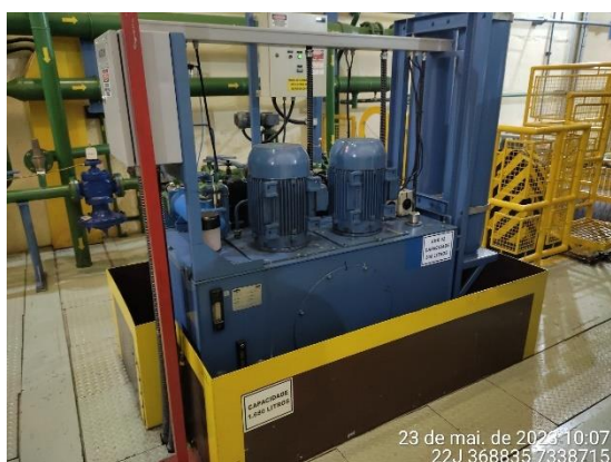
Figura 24 – UHRV da Galeria Mecânica. Fonte: Cedro Inteligência Ambiental, Mai/2023.
