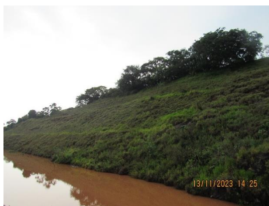
Figura 105 – Aspecto do ponto P22. Fonte: Cedro Inteligência Ambiental, Nov/2023.
