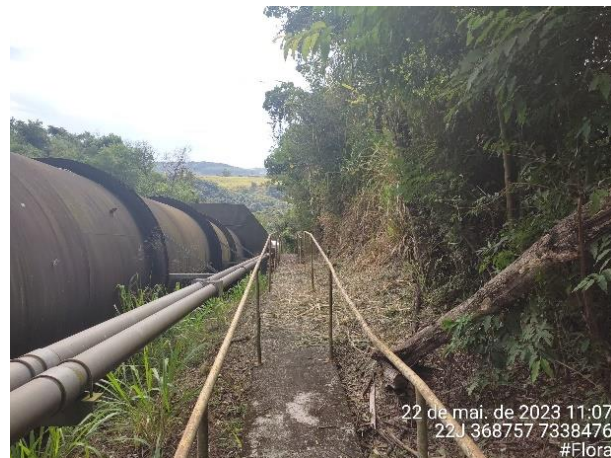
Foto 5 – Vista do conduto forçado da PCH Salto Natal.
