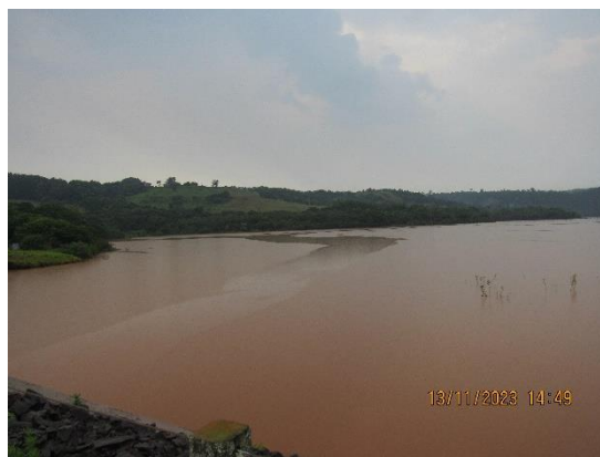
Figura 147 - Vista do barramento do reservatório sem presença de estande de macrófitas.
