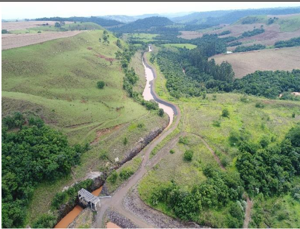
Foto 1 – Registro da TDA e canal de adução da PCH Salto Natal.
