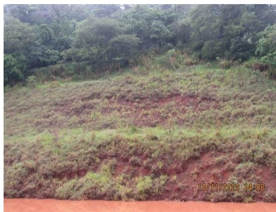
Figura 69 – Aspecto do ponto P2. Fonte: Cedro Inteligência Ambiental, Nov/2023.
