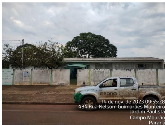
Figura 58 - Escola Municipal Maria do Carmo Pereira. Fonte: Cedro Inteligência Ambiental, Nov/2023.
