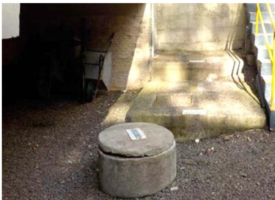
Foto 3-2. STE da PCH Salto Natal - Casa de Força.
