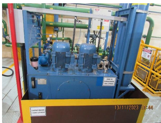
Figura 25 – UHRV da Galeria Mecânica. Fonte: Cedro Inteligência Ambiental, Nov/2023.
