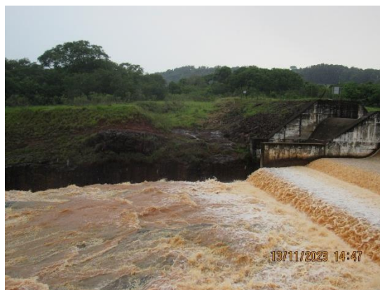
Figura 109 – Aspecto do ponto P24. Fonte: Cedro Inteligência Ambiental, Nov/2023.
