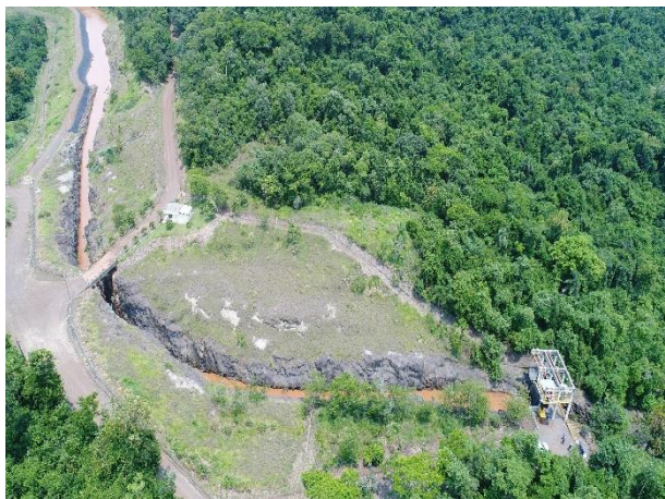
Foto 4 – Vista da câmara de carga da PCH Salto Natal.
